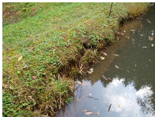
アメリカザリガニの巣穴に起因すると考えられるため池堤体の損壊
