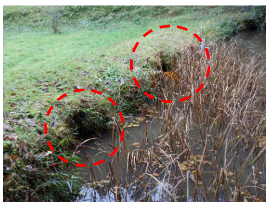
アメリカザリガニの巣穴に起因すると考えられるため池堤体の損壊
